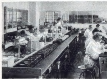
Bild 1. In diesen Montageaum für Feinmeßgeräte darf nur einreten, wer sich für diese Arbeit eisenfrei „zurechtgemacht“ hat (Siemens)
